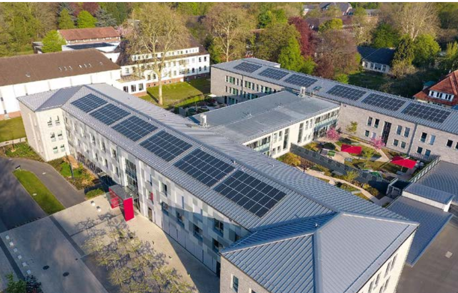
Solarstromanlage auf dem Dach der LWL-Klinik Münster.
