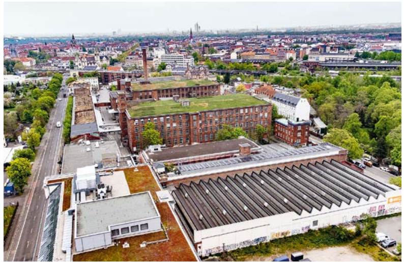
Im Quartier Baumwollspinnerei werden erneuerbare Erzeugungsanlagen digital gesteuert.
