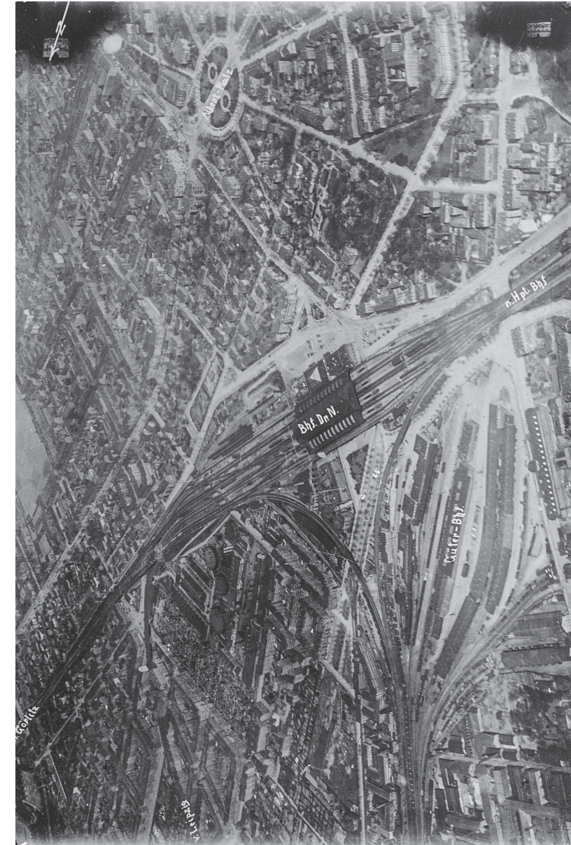
Luftaufnahme des Güterbahnhofs Dresden-Neustadt, um 1930 © SLUB Dresden, Fotothek
