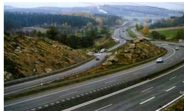
Bundesautobahn A93 Abschnitt Mitterteich - Hof
